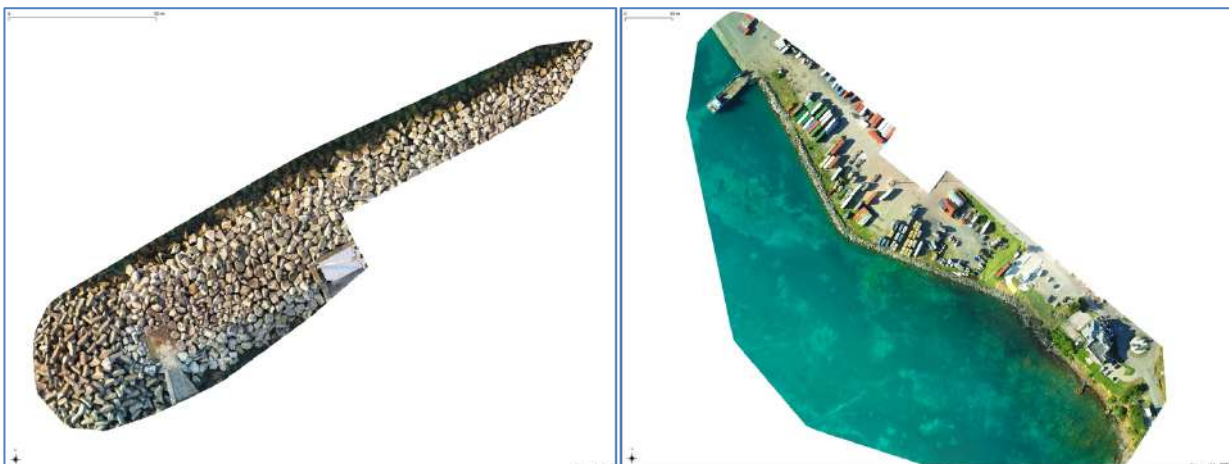
Figure 2 : Orthophotos basse altitude des zones d'expertise – à gauche la digue, à droite l'enrochement
